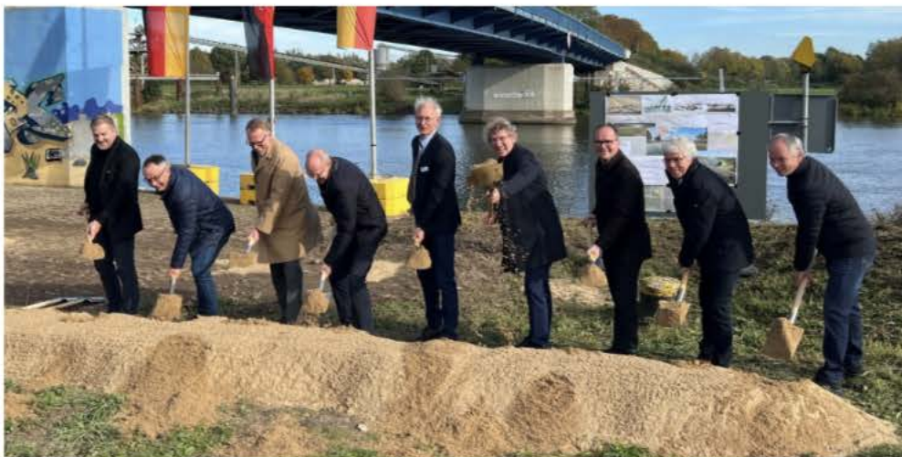
Vertreter aus Politik und Straßenbauverwaltung beim ersten Spatenstich für die neue Stolzenauer Weserbrücke. Diese entsteht im Hintergrund rechts neben der alten.
